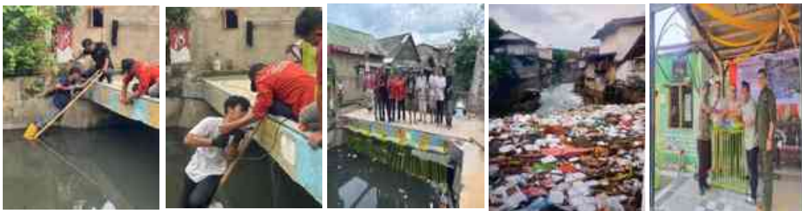
Gambar 5. Pemasangan dan Serah terima Alat Perangkap Sampah di Muara Kali Sukaraja
