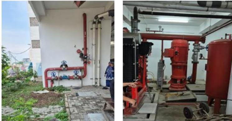
Gambar 3. Foto Ruang GWT di Tower B dan Mesin dan Instalasi Damkar
